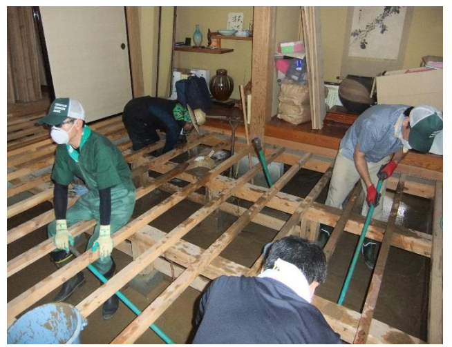
床下の泥だし作業
