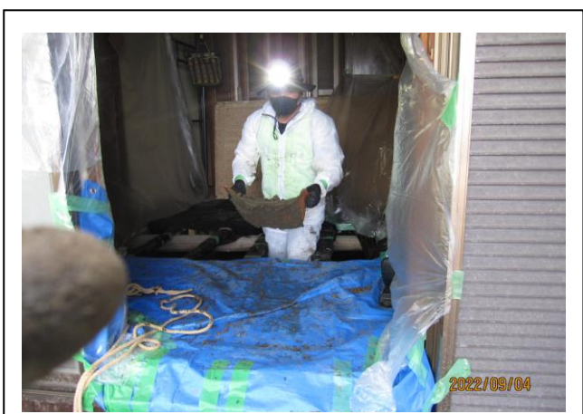
(2)防護服を着て床下の泥だし
