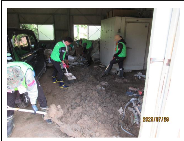
(3)28日 倉庫内の土砂出し
