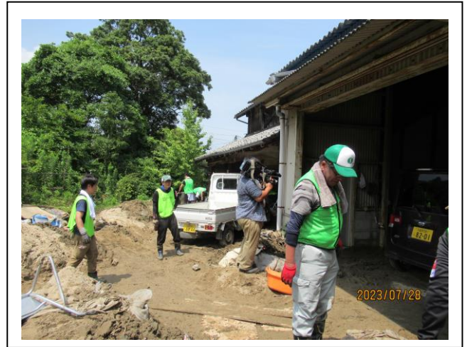
(4)28日 倉庫前の土砂出し
